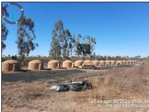
Foto 26: 16 fornalhas em linha na porção Noroeste da área de intervenção.
