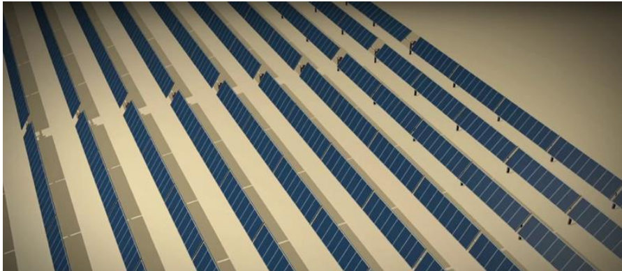
Figura 4.6 - Exemplo de um seguidor de eixo único.
